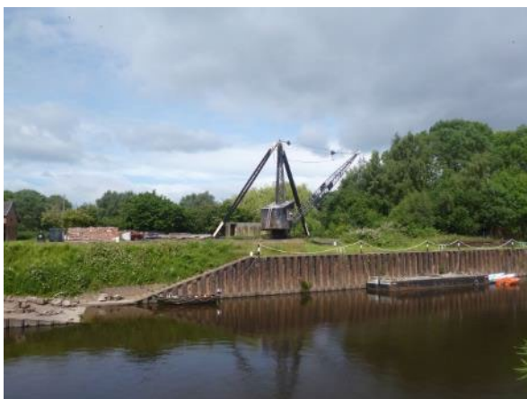
Diglis Island Dock Crane
